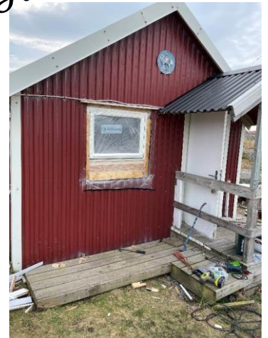
Nytt fönster tidigare
